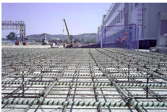
Thi công bê tông cốt sợi tổng hợp
